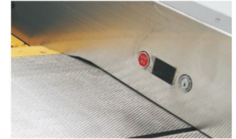
故障显示器 Fault display
