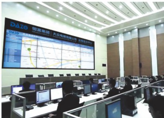
远程监控中心 Remote monitoring center
